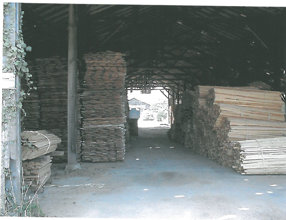
Photo 4 : Bâtiment de stockage du bois traité par trempage (14)
